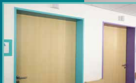
Den Kurzzeitpflege-Bereich im Haus Höhwäldchen prägt ein Farbkonzept. Wie die Türrahmen, sind auch die Zimmer jeweils farblich gestaltet. An Demenz erkrankte Menschen können sich so besser orientieren.
