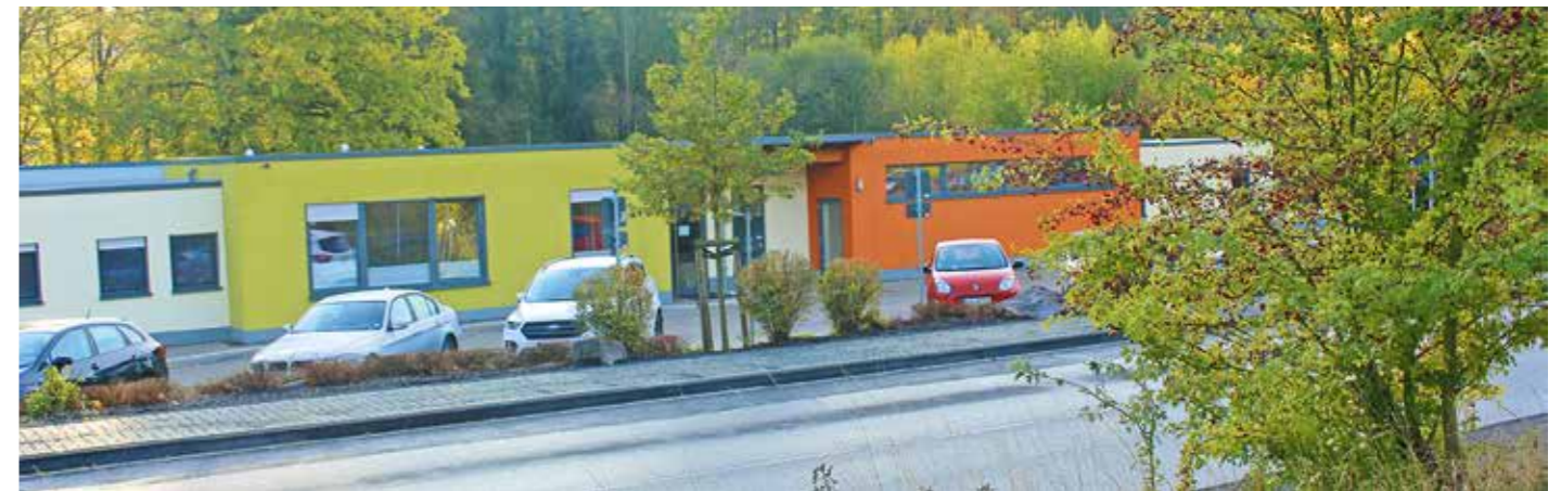
55 Jungen und Mädchen besuchen derzeit den Kindergarten oberhalb des Diakonie Klinikums Jung-Stilling. Nach Abschluss der Baumaßnahme soll es rund 95 Plätze geben. Damit wächst die Einrichtung an der Hengsbachstraße von drei auf fünf Gruppen an.
