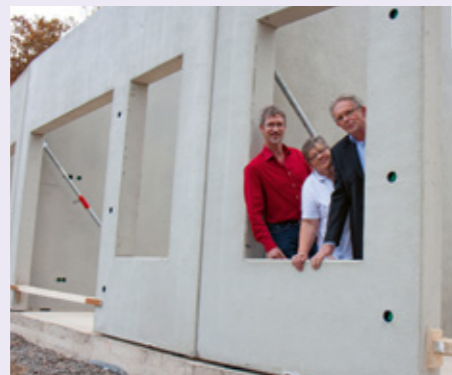
2012 wird der Neubau in unmittelbarer Nachbarschaft zum ehemaligen Standort errichtet.
