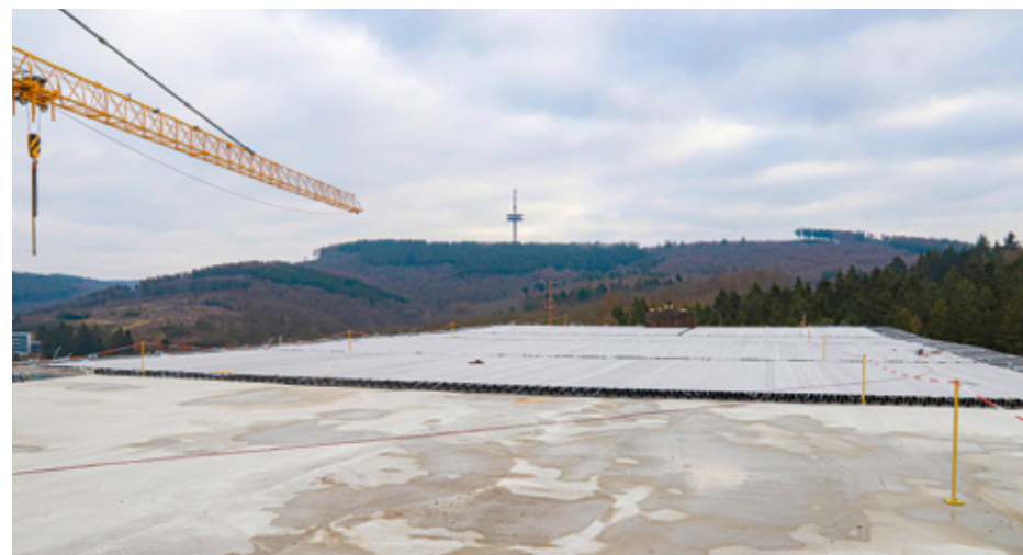
Auf dem Dach des Diakonie Klinikums Jung-Stilling entsteht das neue Hubschrauber-Landedeck nebst Hangar. Im April sollen dort die ersten Starts und Landungen erfolgen.
